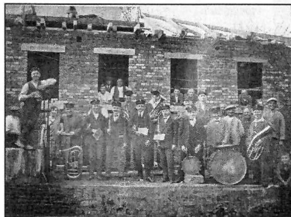
Beim Richtfest des Anbaus
