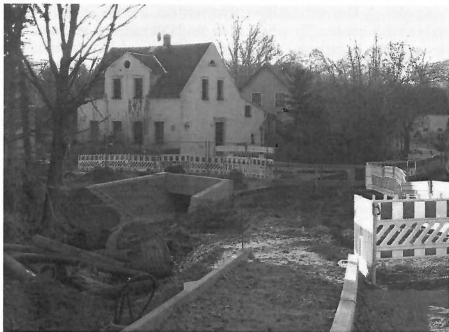
Die neue Brücke, vom Oberdorf kommend gesehen
